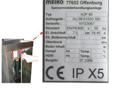
Das Typenschild mit den elektrischen Anschlusswerten befindet sich hinter der Revisionstür.
